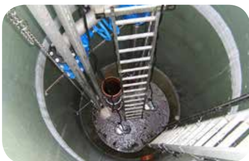
Blick in den Schacht
