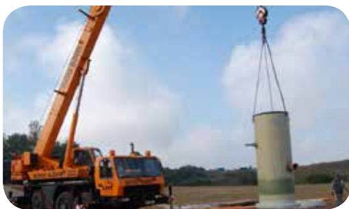
Anlieferung des vorinstallierten GFK-Schachts
